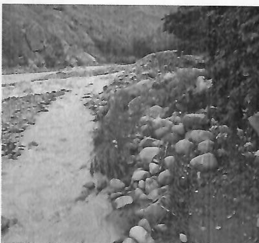
2.5 Línea de conducción de ventana de captación a planta de tratamiento: es de tubería HDPE polietileno de alta densidad que está enterrado hasta una caja de reunión siendo vulnerable a colapso por socavamiento del flujo del río.
