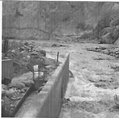
2.3 Muro de encauzamiento de captación: se necesita proteger la parte delantera de la planta de captación.
