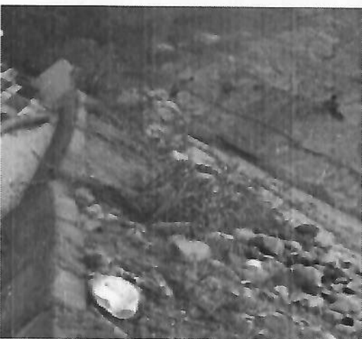
2.5 Línea de conducción de ventana de captación a planta de tratamiento: es de tubería HDPE polietileno de alta densidad que está enterrado hasta una caja de reunión siendo vulnerable a colapso por socavamiento del flujo del río.
