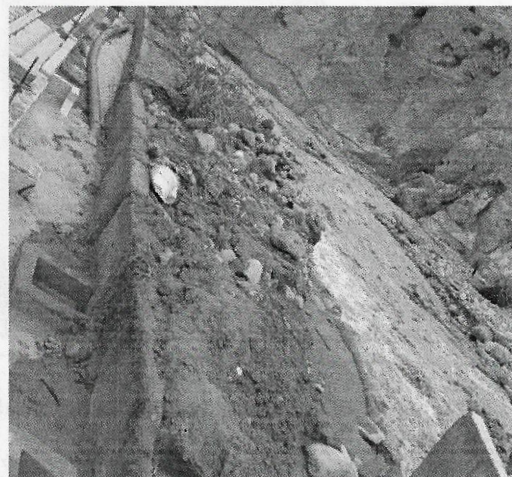
a.2.6 Tubería de evacuación de lavado de filtros: esta tubería es importante ya que evacua las aguas producto de lavado e filtro.
