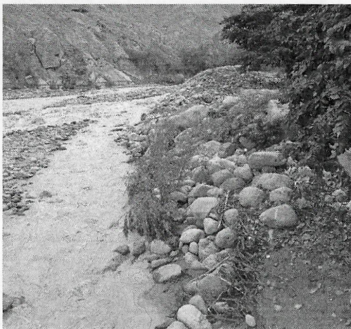
a.2.5 Línea de conducción de ventana de captación a planta de tratamiento: es de tubería HDPE polietileno de alta densidad que está enterrado hasta una caja de reunión siendo vulnerable a colapso por socavamiento del flujo del río.
